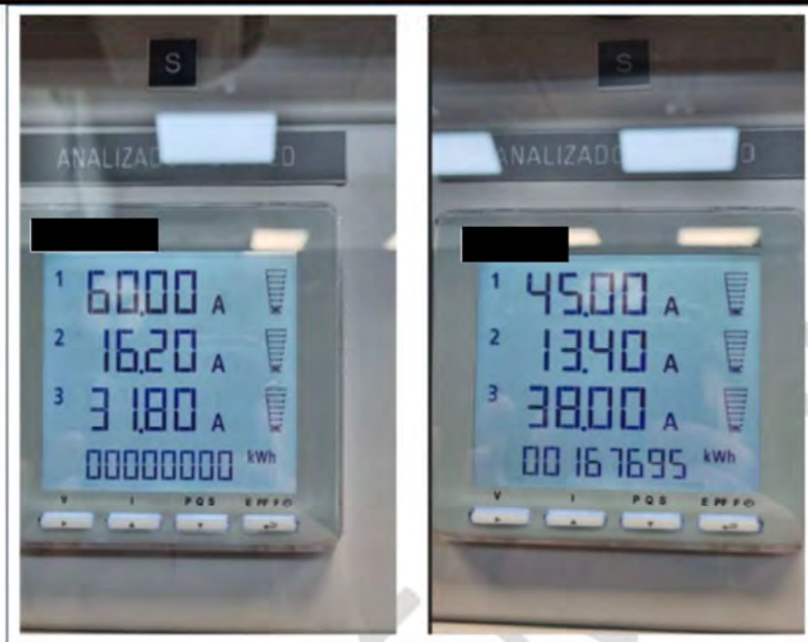
Figura 4. Carga de sistemas UPS edificio CNOT
